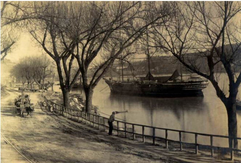
Alameda de Massarelos, 190? Arquivo Histórico Municipal do Porto
