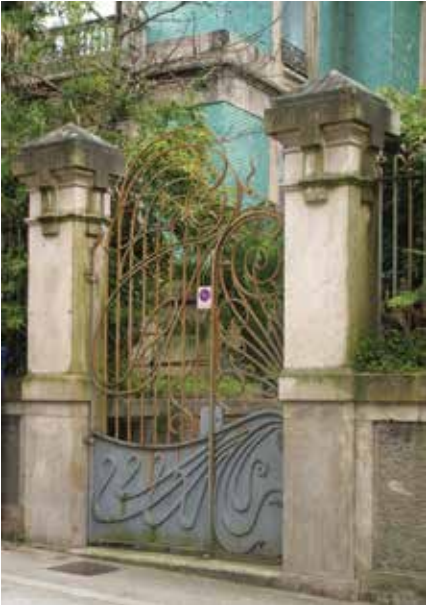
Portão «Arte Nova» Rua do Bonjardim Fotografia de Luís Aguiar Branco
